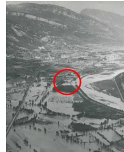
Illustration d'une rupture de digue de l'Isère au Bec de l'Echaillon en 1948
